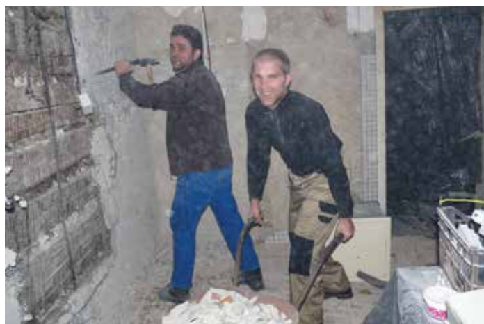
Během práce na rekonstrukci interiéru chaty na Prašivé
